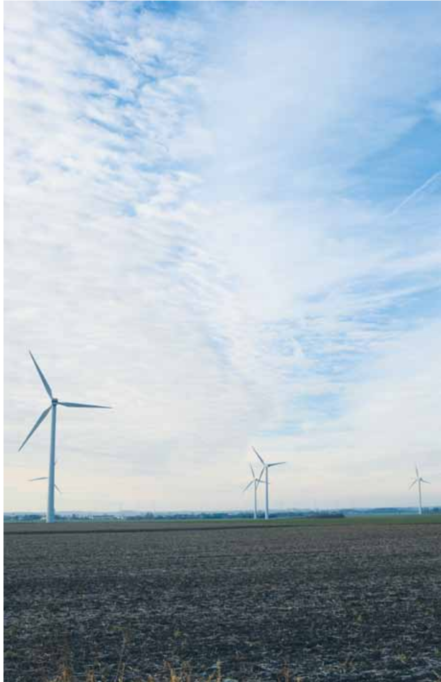
Etwas Neues wird entstehen! Im deutschen Wörbzig werden von der W.E.B zwölf Alt-Anlagen durch sechs neue, leistungsfähigere Anlagen ersetzt.
