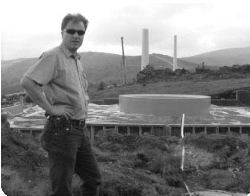
Andreas Dangl auf der Baustelle des Tauernwindparks.
