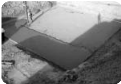
Fundamentarbeiten im Windpark Altentreptow
