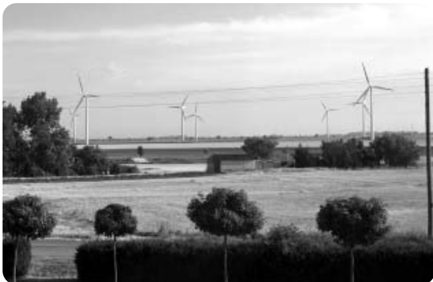
Der Windpark Wörbzig wird um 3 Anlagen erweitert.
