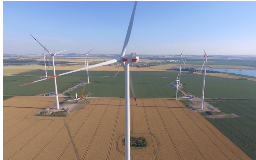
Windpark Wörbzig in Deutschland, mit der produktionsstärksten Anlage im Monat Februar (Wörbzig RI: 1.758 MWh).
