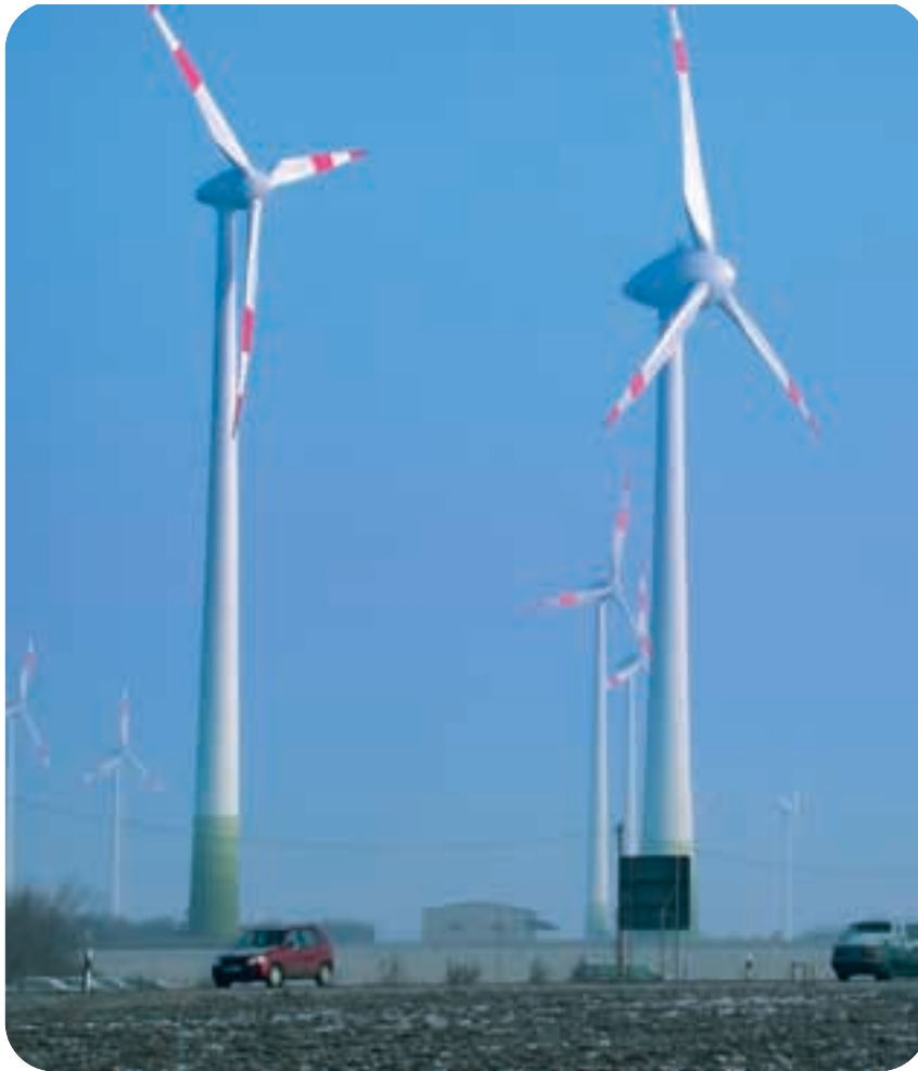
Der Prototyp der Enercon E112, der größten Windkraftanlage der Welt bei Magdeburg (Turmhöhe: 120 Meter, Rotordurchmesser: 112 Meter, Nennleistung: 4,5 MW). Links eine Enercon E66/1,8 MW
