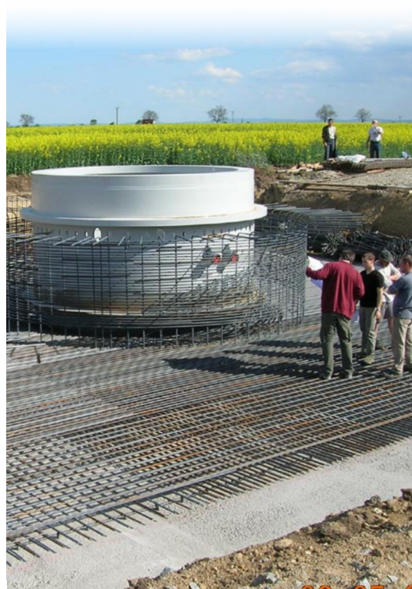
Fundamentierungsarbeiten auf der WEB-Baustelle in Bantice, Tschechien
