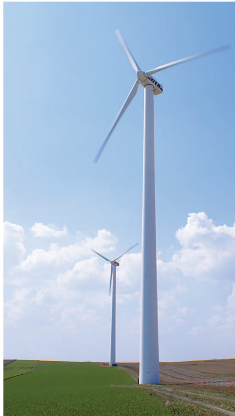
Windpark Oberstrahlbach – Einer der ersten Standorte (Anlagen No. 5, 6 und 7) der WEB Windenergie AG.
