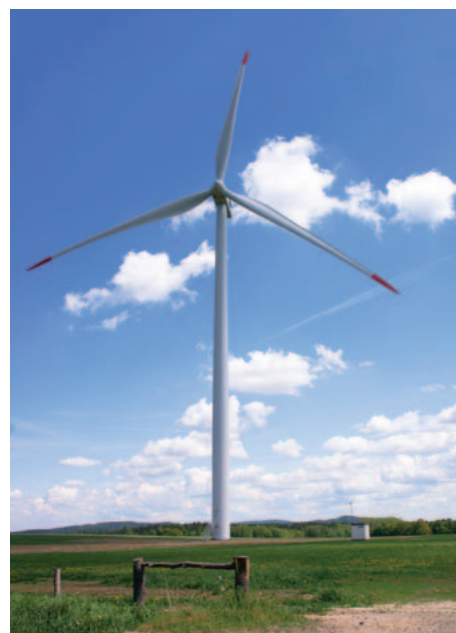
Die erste Anlage der W.E.B mit 100 m Rotordurchmesser
