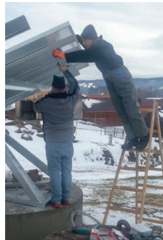
Roman Prager mit W.E.B-Kollegen Markus Höllrigl bei der Montage des PV-Trackers.
