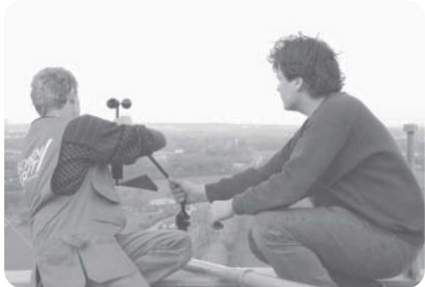
Montage eines Anemometers in schwindelnder Höhe
