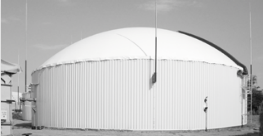
Fermenter mit der Gashaube , die senkrechten Stangen sind Blitzschutz
