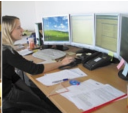
Kommunikationstechnik in der Leitzentrale.
