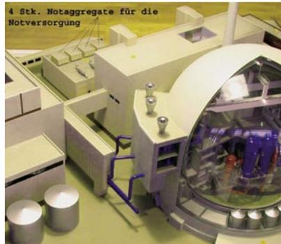
Der Reaktor mit den Kühlwasserpumpen befindet sich im rechten Bildbereich, links hinten sind die vier Notstromblöcke zu erkennen.
