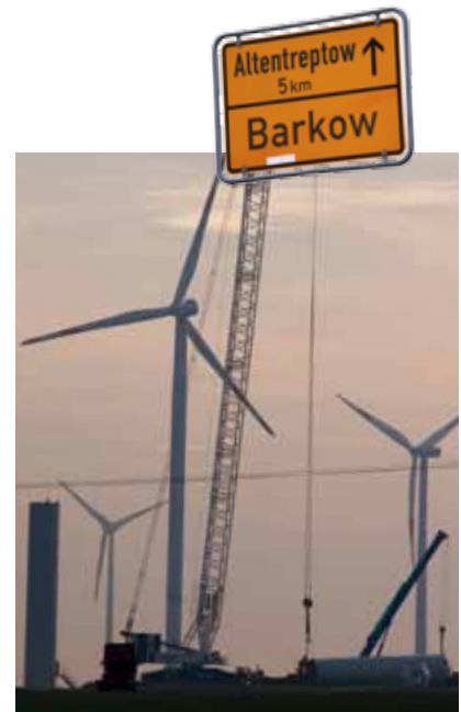
Montagearbeiten in Barkow
