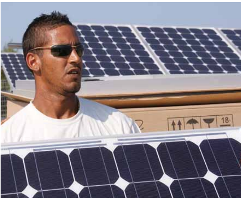
Modulmontage in Montenero di Bisaccia, Italien
