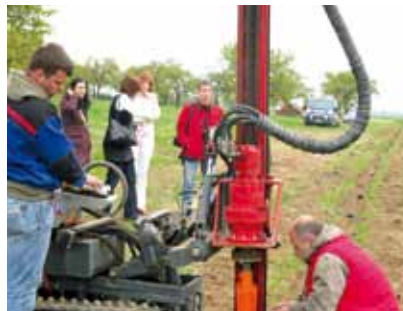
Bauarbeiten in Dobšice, Tschechien
