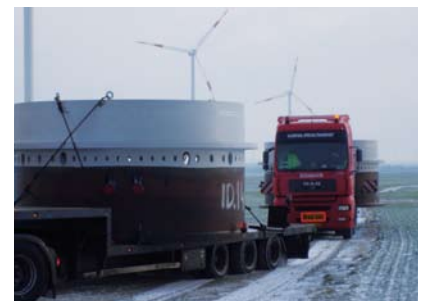
Der Fundamentring für die V90 wurde Anfang Jänner geliefert.
