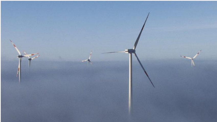
Mehr als 5.024 Quadratmeter Rotorkreisfläche haben die V 80 in Altentreptow. Vier Quadratmeter decken in etwa den jährlichen Strombedarf einer vierköpfigen Familie.
