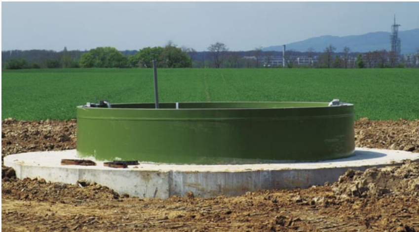
Enercon und General Electrics bevorzugen Fundamente in Zylinderform ...
