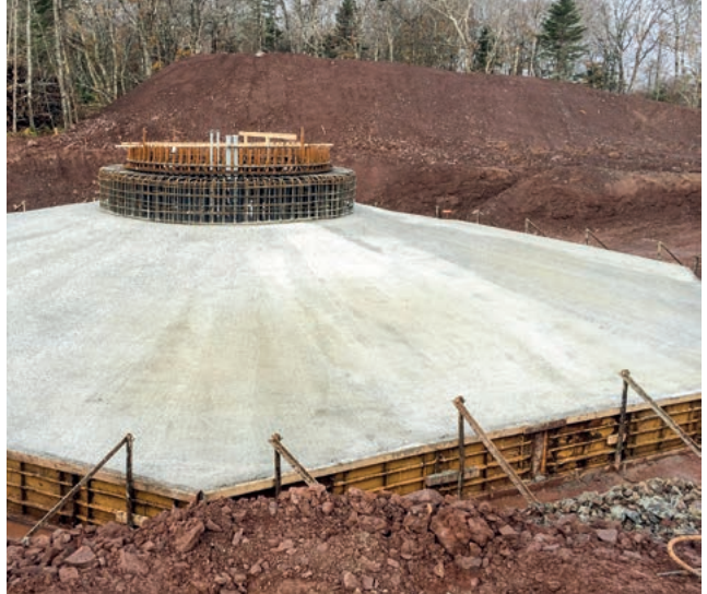
Das Fundament am Standort Baddeck in der Bauphase.
