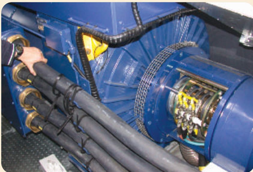
Generator einer Vestas V80/2MW
