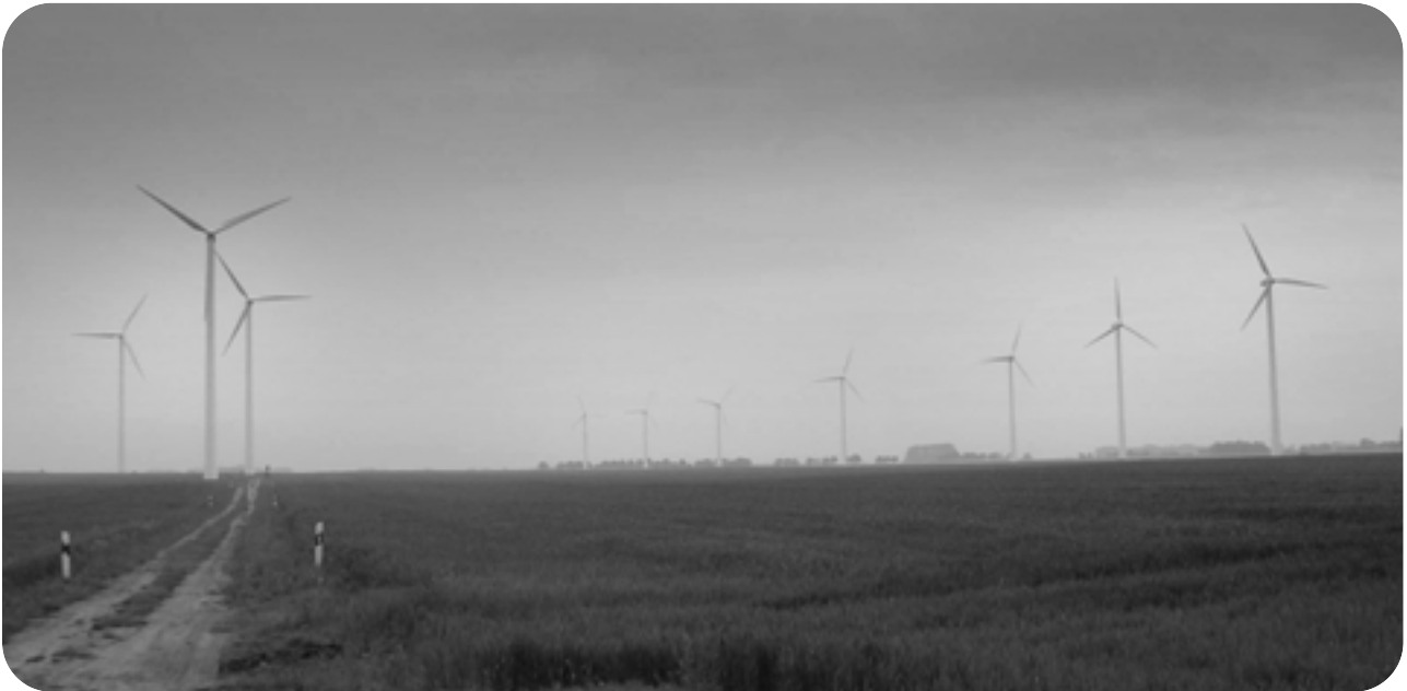
Der Windpark Görmin, die WEB – Anlage ist im Bild die dritte von links.
