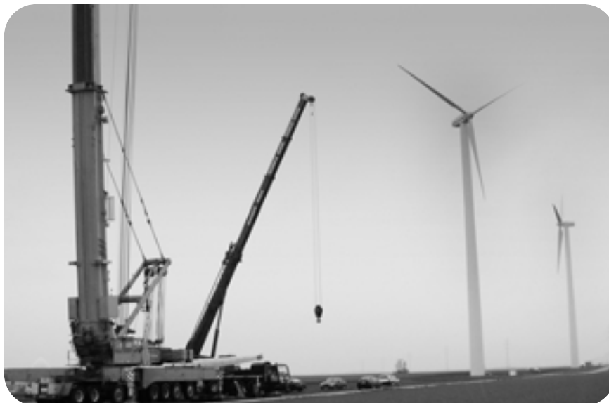
Am 20. März wurde trotz widriger äußerer Bedingungen die dritte Anlage errichtet.
