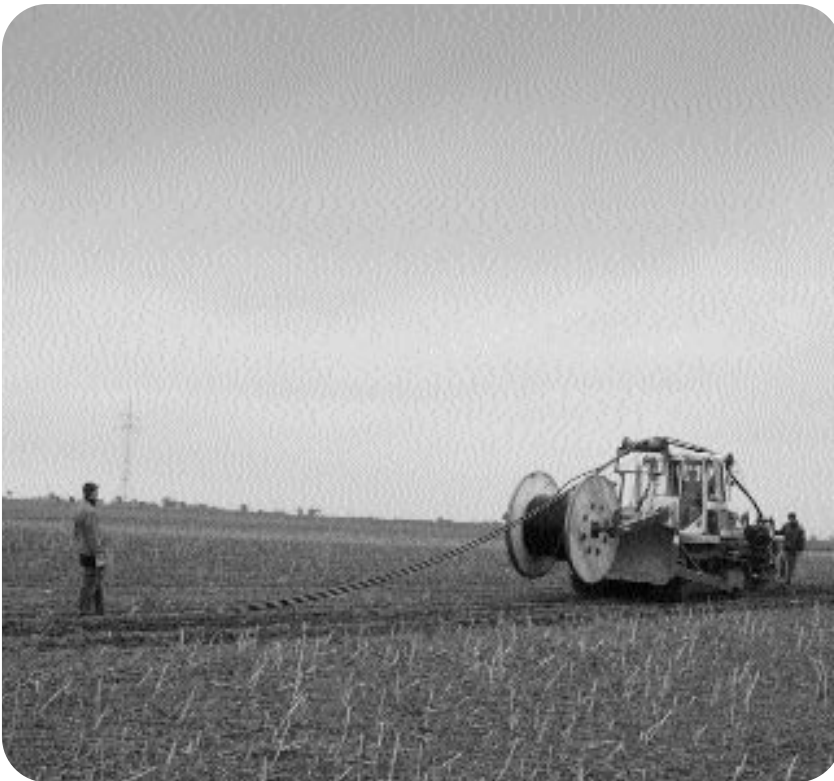
Kabelverlegearbeiten im Windpark Wörbzig
