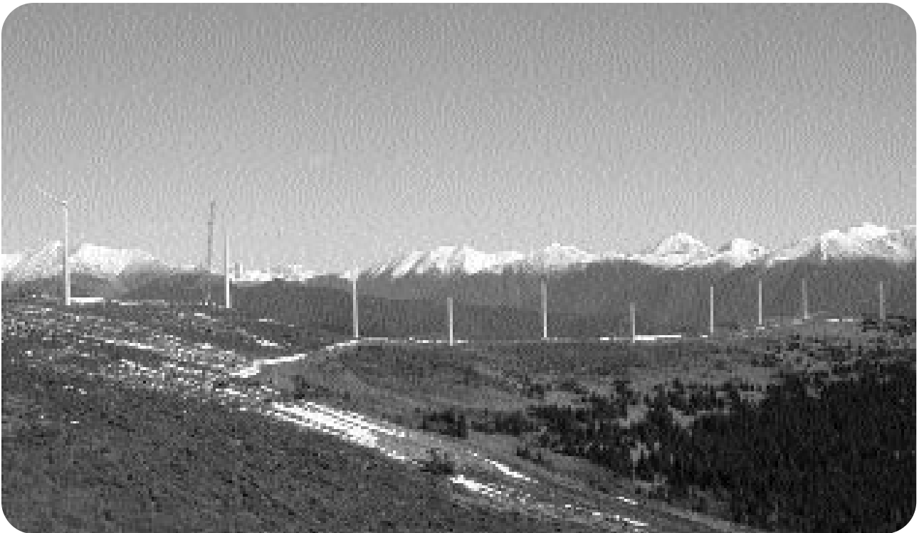
Der Tauernwindpark am 30. September 2002: Die Endmontage der 2. Anlage ist in vollem Gang
