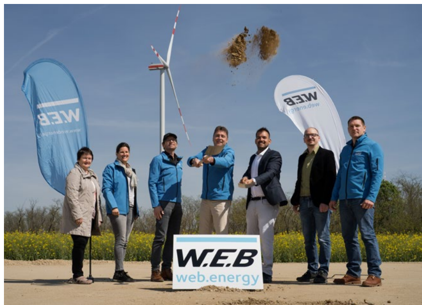
Spatenstich im Burgenland: Zwei neue Windräder ersetzen demnächst zwei Altanlagen.
