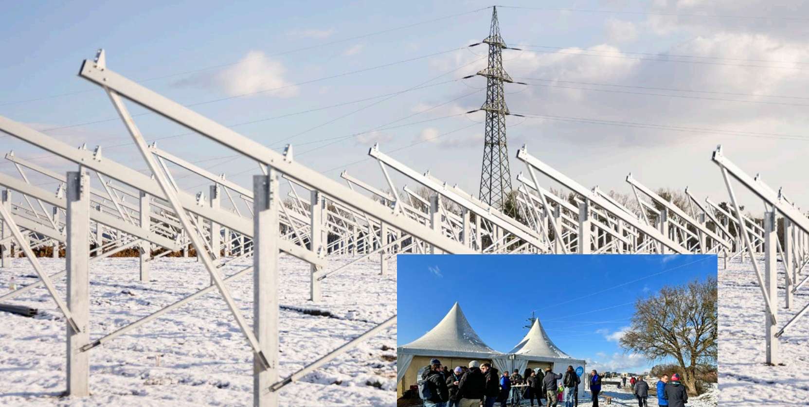
Baustellentag in Rohr bei Hartberg
