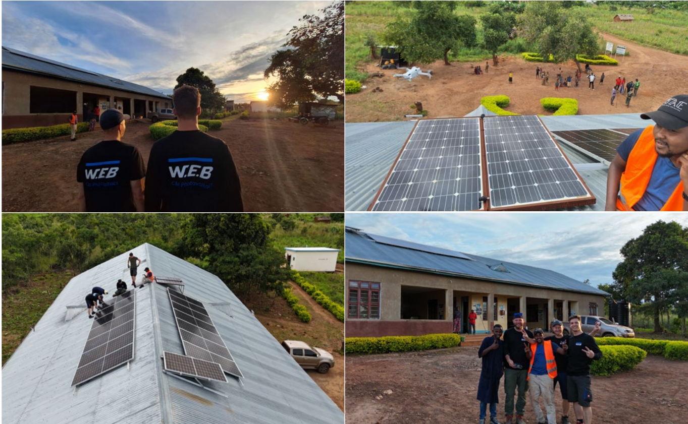
W.E.B.-Mitarbeiter unterstützen bei der Installation vor Ort in Tansania
