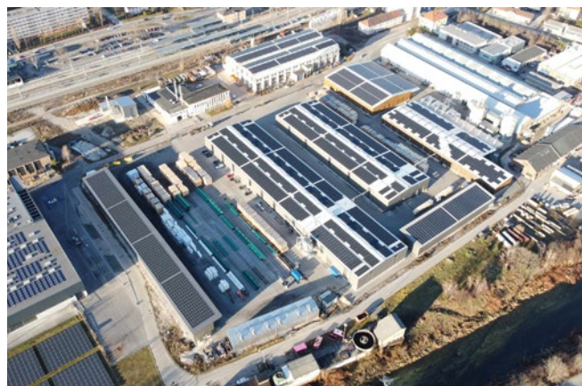
So sieht die größte Aufdach-Anlage von oben aus
