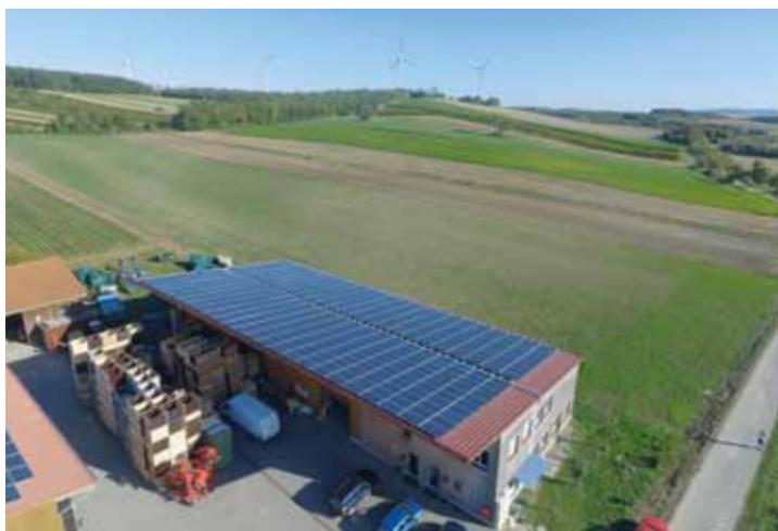
Ein Schnappschuss mit der Drohne aus Sigleß! Hier befinden sich W.E.B-Windenergieanlagen und W.E.B-PV-Anlagen nicht weit voneinander entfernt. Die PV-Module wurden diesen Sommer im Rahmen der KMU-Energiewendepartnerschaft am Biohof Artner installiert.
