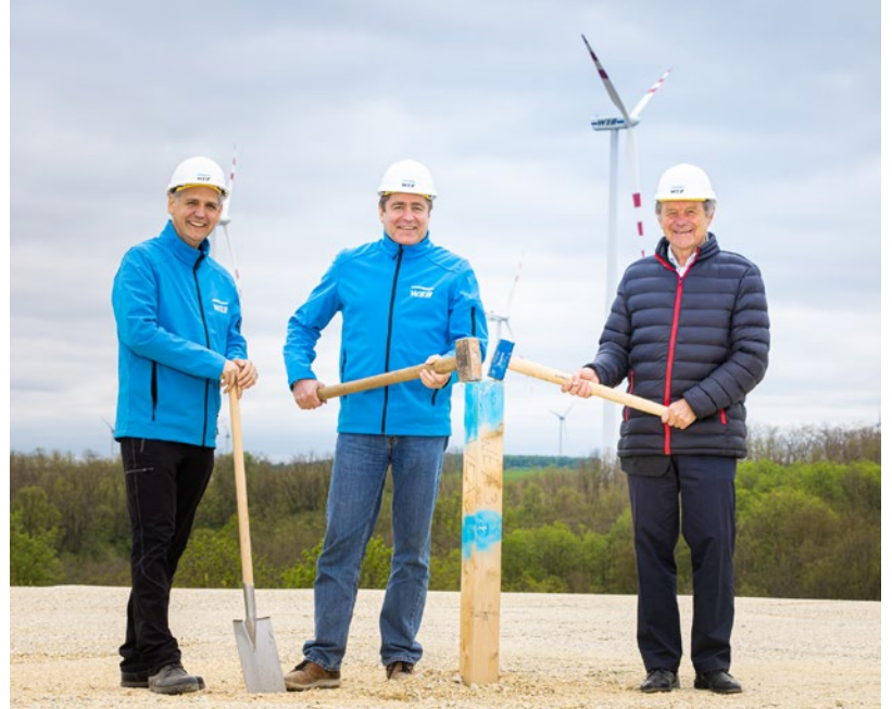
Spatenstich in Spannberg! Bürgermeister Herbert Stipanitz markierte mit Frank Dumeier und Michael Trcka die Fundamentmitte.
